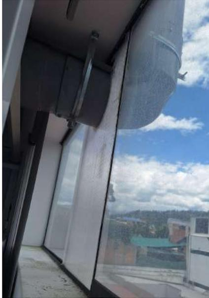
**Figura 2:** Fotografía referencial de acondicionamiento de ventana para salida de tubería de desfogue
