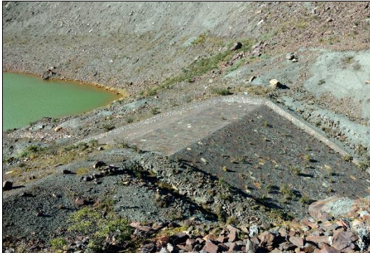
Fotografía N° 19.- Vista panorámica del dique de seguridad.
