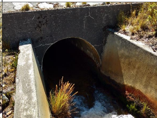
Fotografía N° 24.- Vista del Conducto de TMC de 60” de diámetro.
