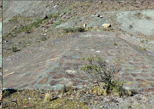
Fotografía N° 20.- Vista de la corona de la presa.
