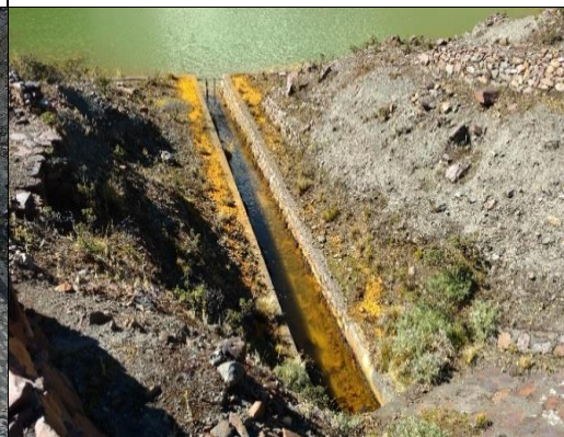
Fotografía N° 22.- Canal de entrada hacia el conducto cubierto.
