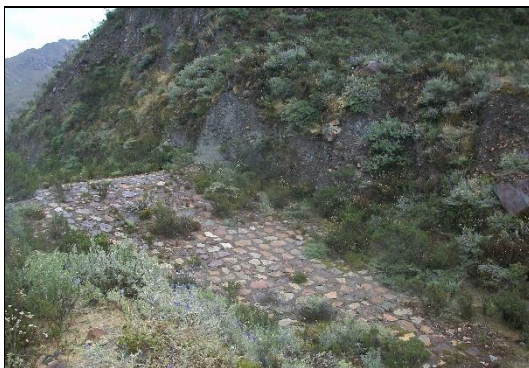
Fotografía N° 13.- Vista panorámica del dique de seguridad.
