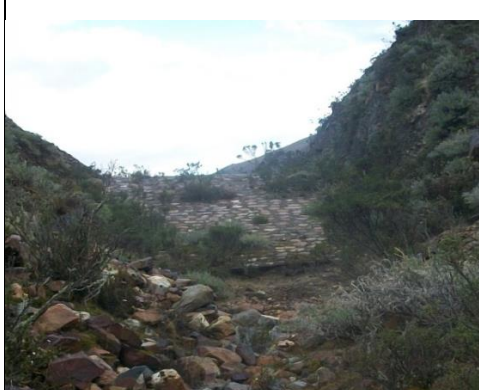
Fotografía N° 15.- Vista del talud aguas arriba o cara interior de dique.
