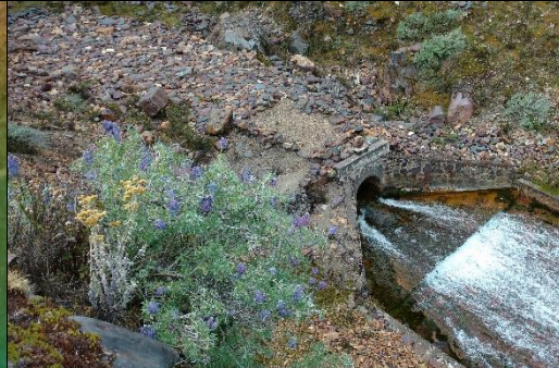
Fotografía N° 18.- Se muestra la salida del túnel de descarga con su respectiva estructura de salida (Aletas y losa).
