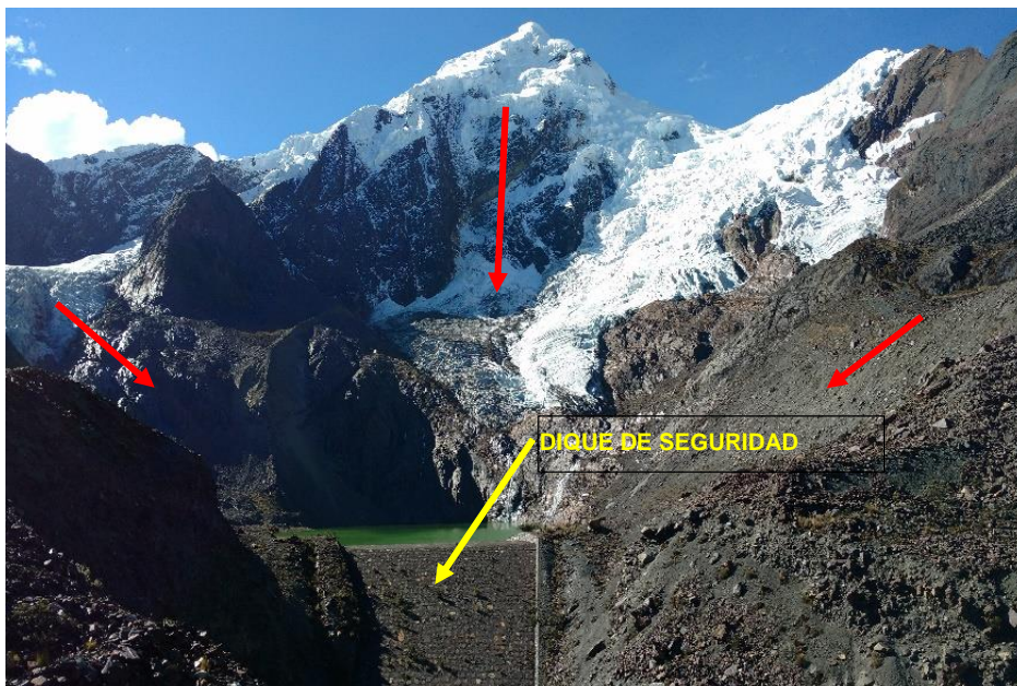
Fotografía N° 35: Laguna Cuchillacocha y dique de seguridad, resaltando las zonas de posible desprendimiento de masas glaciares y morrenas sobre la laguna.
