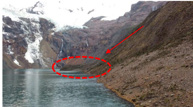
Fotografía N° 32: Morrena lateral izquierda, con zonas inestables y gran cantidad de material sobre la laguna, la cobertura vegetal es rala sobre laderas con fuerte pendiente.
