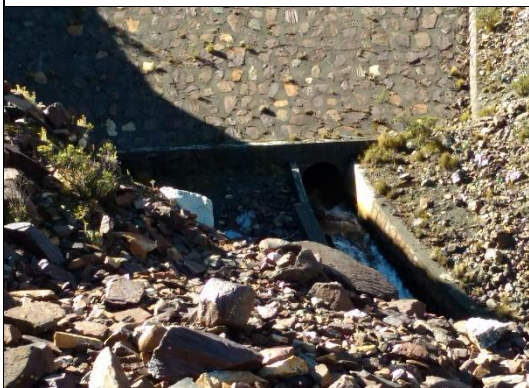
Fotografía N° 23.- Vista del canal de salida.
