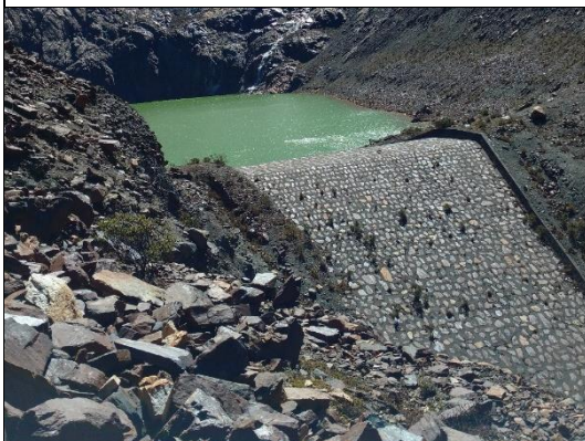
Fotografía N° 21.- Vista del talud aguas abajo o cara exterior de dique.
